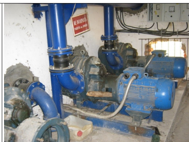
Рисунок 13.2.6 – Воздуходувные компрессоры ОСК
