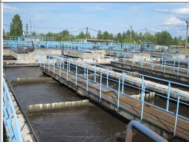
Рисунок 13.2.4 – Резервуары-отстойники ОСК
