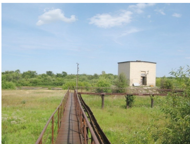
Рисунок 6.4.1 – Здание существующего водозабора и НС-1
