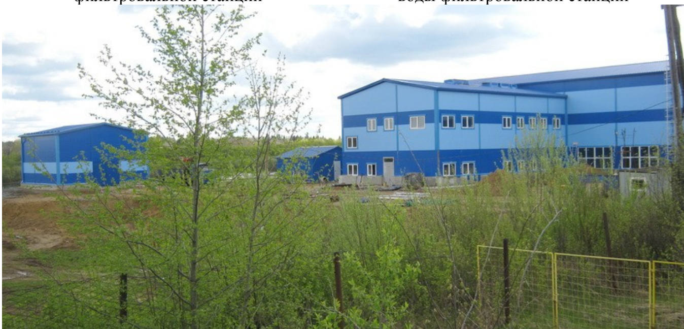
Рисунок 6.4.7 – Строящийся новый водозабор со станцией очистки воды
