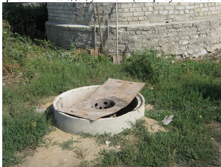
Рисунок 13.3.1 – Колодец для приема ЖБО у КНС-2
