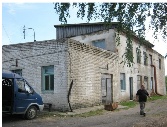
Рисунок 6.4.2 – Здание станции очистки, НС-2 и котельной,
