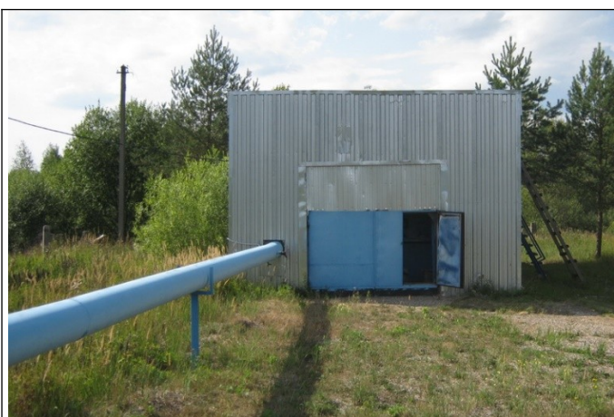
Рисунок 13.2.5 – Здание компрессорно- воздуходувной станции ОСК
